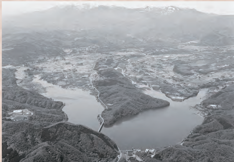
昭和45年 釜房ダムが完成
