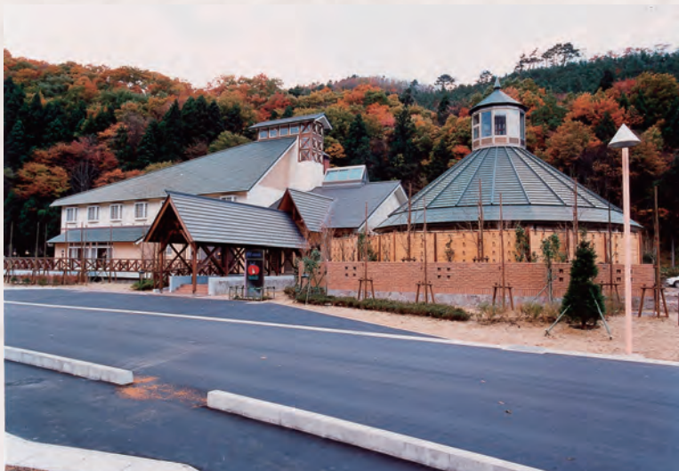
平成8年 交流促進センター「るぼわかわさき」が完成
