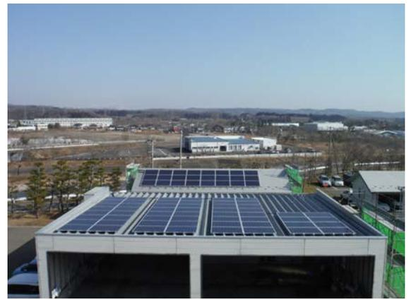
写真：公共施設に設置した太陽光発電パネル
