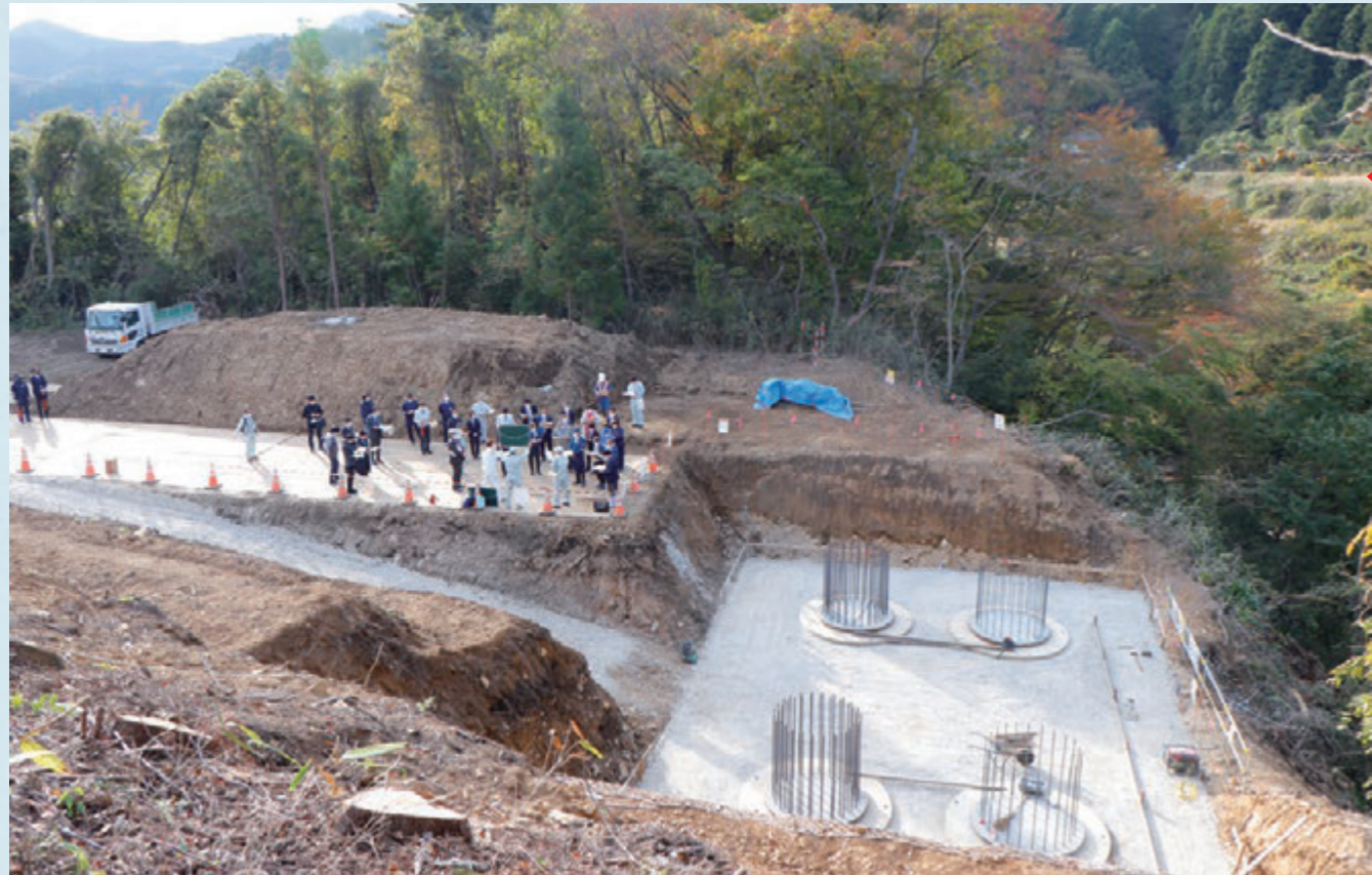
宮城県（川崎町）の工区は1.3キロ。支倉台入口から始まり碓石川に橋を架け、対岸にトンネルを掘り、もう一つの橋を架けるまで。今年度は橋の土台（写真右下）と対岸の土台を作ります。対岸の土台を作るため（写真右上の矢印の所から）仮設道路・仮橋の工事も進めます。
