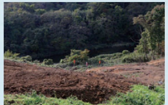
1号橋を架けるための下部工事が進行中
