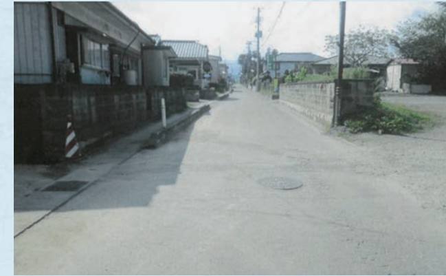
施工前 左手前の縁石が気になり、右側にはブロック塀。(株)チバ電気システムサービス様前から役場に向かって。
