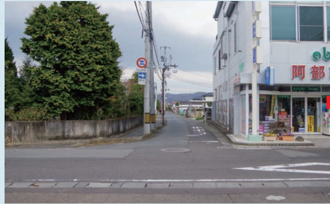
施工前 電柱と街灯があり車が進入しにくそうです。JA農協様の駐車場より阿部薬局様に向かって。
