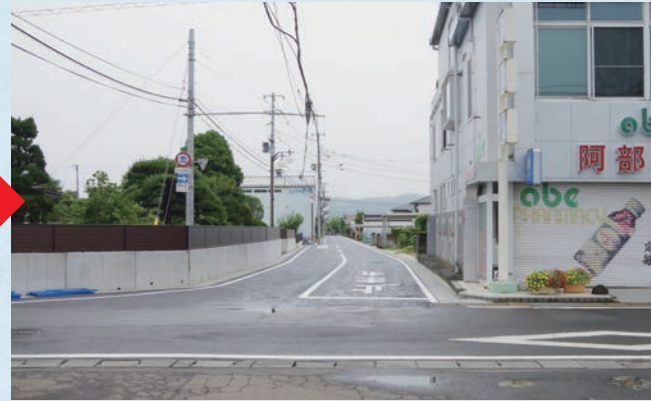
施工後 左のお宅の土地を少し買収し、併せて電柱も移動しました。感謝。
