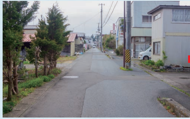
施工前 右手前の縁石、電柱と街灯も微妙な位置です。佐藤石材店様の北側からJA農協様に向かって。
