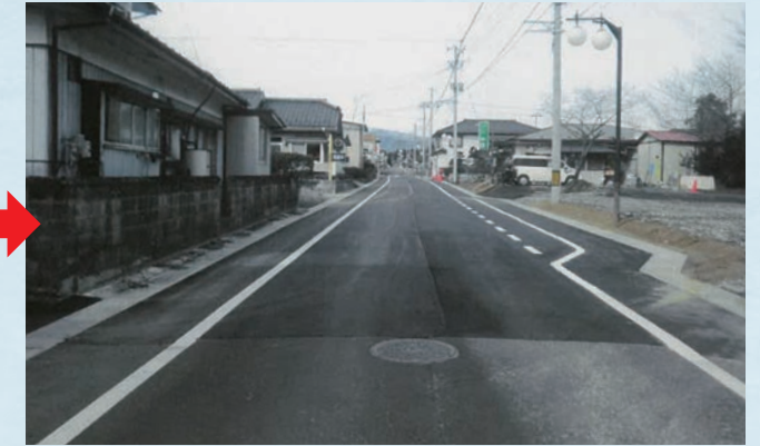
施工後 縁石が取り払われ、ブロック塀も撤去。電柱や街灯も移動。広々として車同士のすれ違いも容易。
