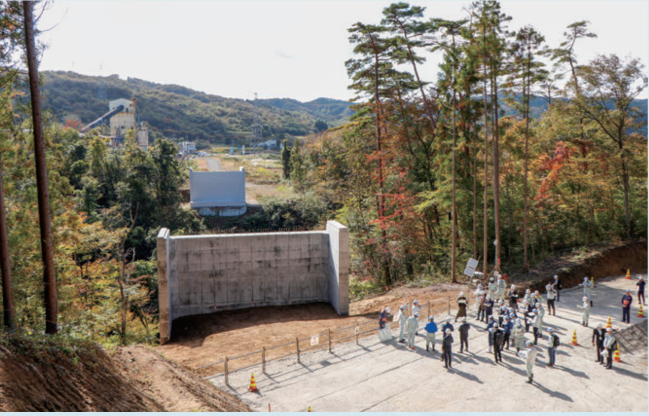
碓石・川向地区の現場より仙南生コン様・プラント方面を臨む。川崎町の現場が宮城県の工区で1.3キロ。碓石から仙南生コン様付近より碓石川を横断する橋の橋台が完成しつつある。橋台間の距離は約93メートル。碓石から赤石まで3つの橋と2つのトンネルで結ばれる予定。手前では、大河原土木事務所・副所長さんの説明が始まっている。
