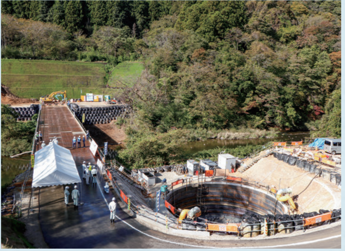
仙台市の工区は1.4キロ。赤石のコンビニの付近から始まり、赤石パーキング・トイレの脇に交差点が新設され、川崎方面に向かって道路が延長、碓石川を渡る橋が架けられトンネルへ。写真の左側に工事用の仮橋、右手前には橋脚の基礎部。向こう岸にも作られ全長207メートルの1号橋梁を支えることに。
