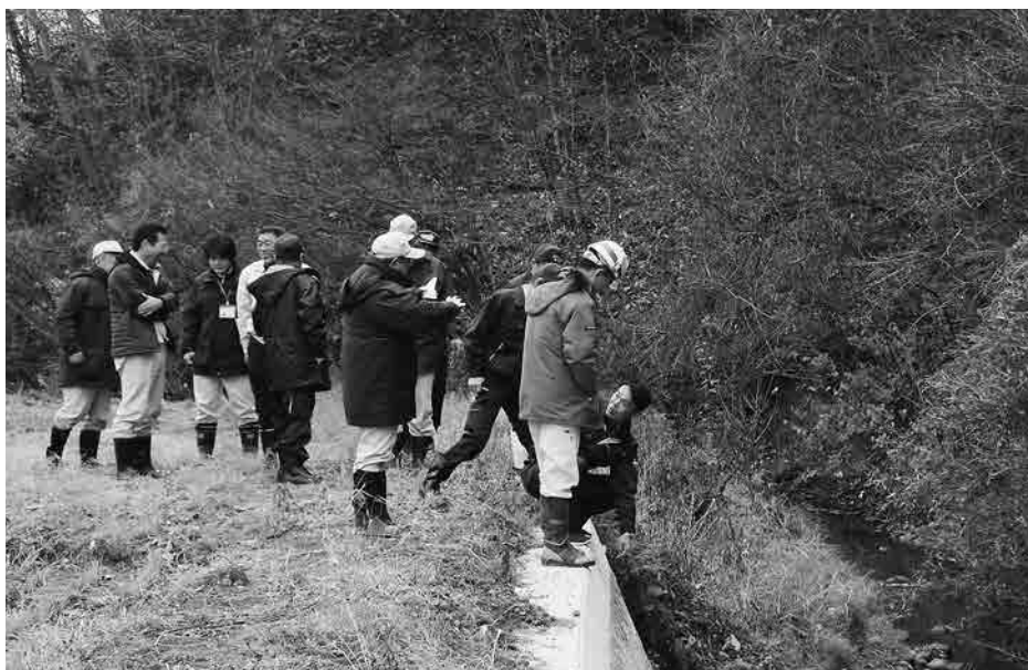
▲支倉地区水路復旧現場
