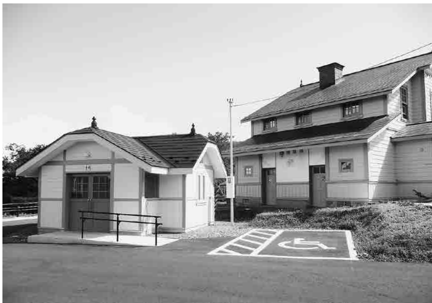
▲新設された公衆トイレ
