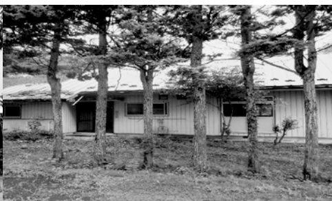
▲解体予定の旧合宿所
