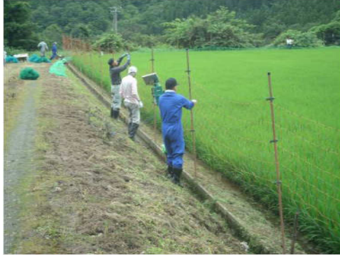
鳥獣害防止電気柵の取付作業
