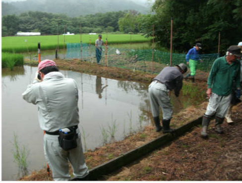
鳥獣害防止電気柵の取付作業
