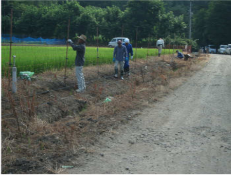
鳥獣害防止電気柵の取付作業
