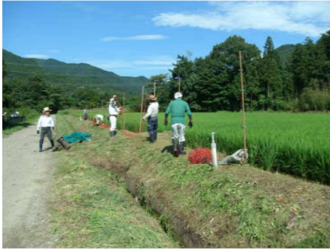
鳥獣害防止電気柵の取付作業
