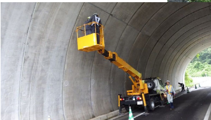
トンネルはアーチ型のコンクリートで構成
