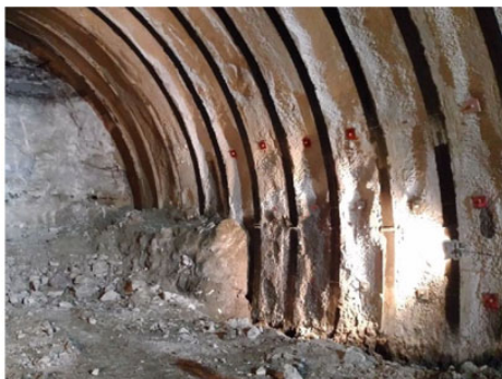
トンネル内の覆工は無筋コンクリート
