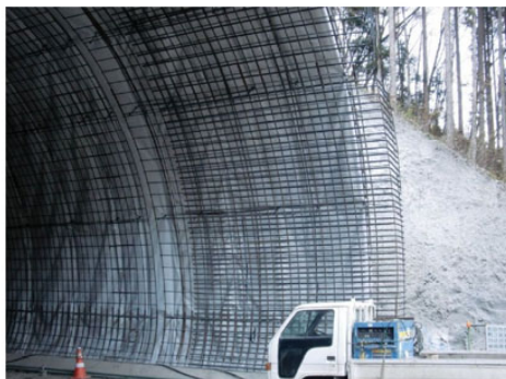
坑口部の覆工は鉄筋コンクリート
