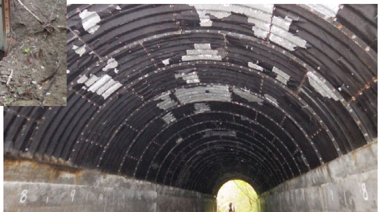
トンネル内部は金属板で覆われている
