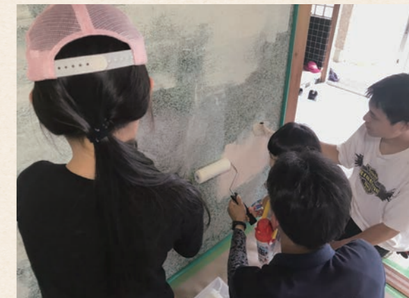
▲壁塗り作業中。ローラーでコロコロ塗りました。
