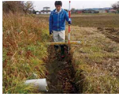
▲改修を予定している野上地区の用水路。
